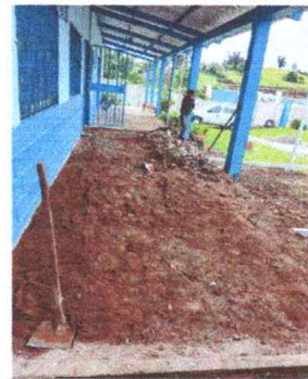
Foto 4: DEMOLICIÓN DE PISO DE CORREDO PRINCIPAL DE LA ESCUELA Y ESCENARIO.
