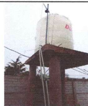
Foto 6: REEMPLAZO DE ROTOPLAS, NECESARIO PARA EL ABASTECIMIENTO DE AGUA
