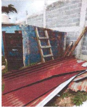
Foto1: DEMOLICIÓN DE CUBIERTA DE LÁMINA Y ESTRUCTURA DEL TECHO DE SANITARIOS.
