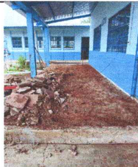
Foto 5: VISTA AMPLIA DE LA DEMOLICIÓN DEL PISO DEL PASILLO PRINCIPAL Y ESCENARIO DE LA ESCUELA.
